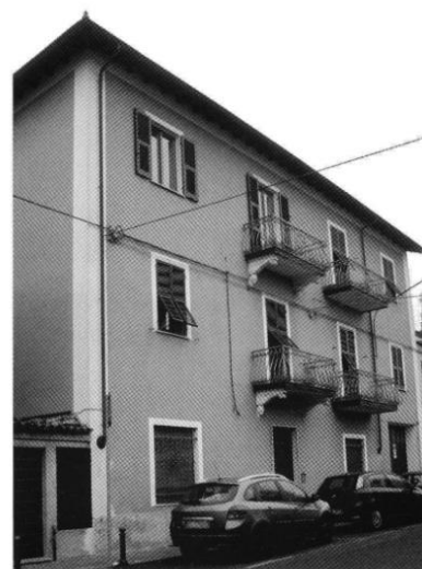
▲► In alto: foto d'epoca di una "trunera" in via Vittorio Veneto, con pilastri di mattoni e mensole degli affacci incastrate nella terra battuta. A lato: nell'edificio, ristrutturato radicalmente, non sono più leggibili tracce dell'assetto originario.
